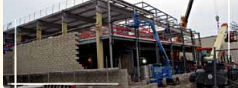
Installation de la charpente métallique...
